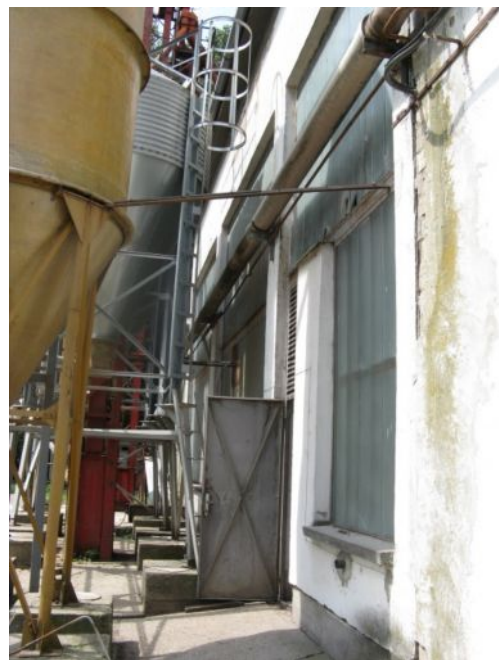
Takarmánysiló szerelőlétrájának védőkarimája kb. 4 méteres magasságban kezdődött
