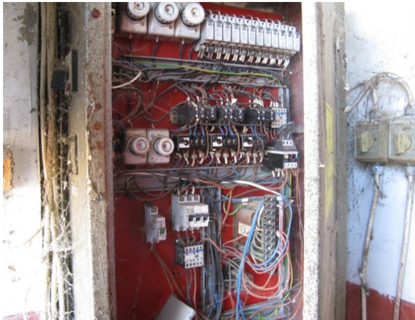
400V-os villamos kapcsolószekrény ajtószervezete nyitott állapotban volt, a villamosan aktív részek kézzel érinthetőek voltak
