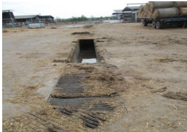
A fedetlen hígtrágya kifolyó csatorna
