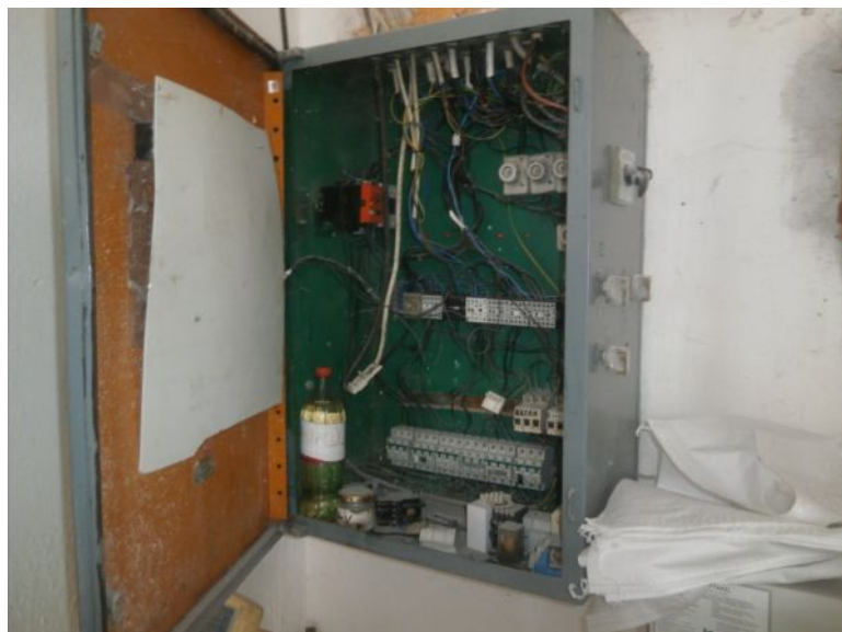
A ventillátor 400V-os villamos kapcsolószekrénye nyitott állapotban, benne üdítőitalos flakonban gyomirtó tárolása
