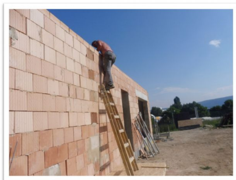
Kétágú létra támasztólétraként történő használata
