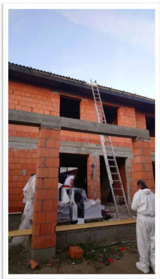
A képeken látható támasztólétráról zuhant le a munkavállaló
