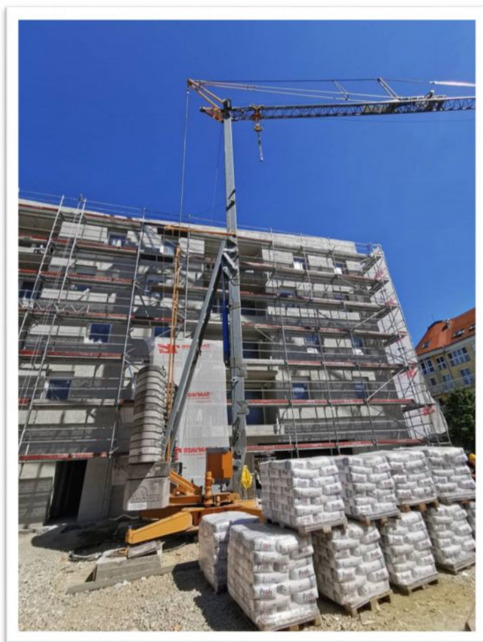
Szabályosan kialakított állványzat, rendezett munkaterülettel
