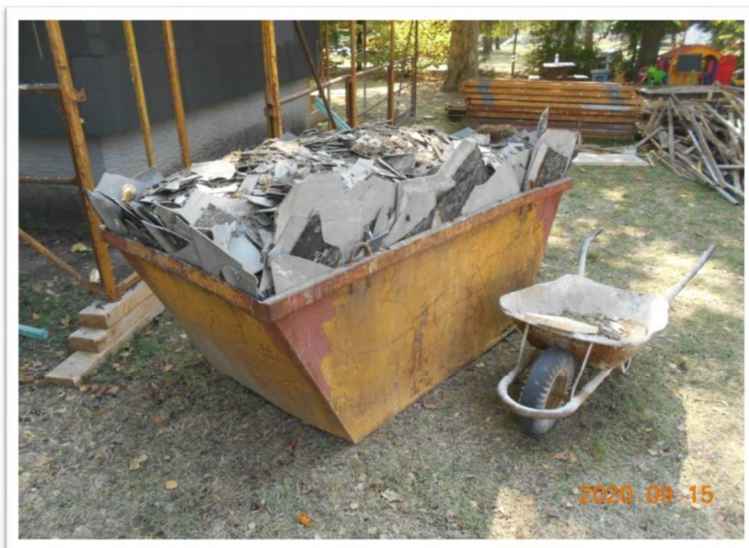
Bontási munkák során fém konténerben, és a konténer mellett egy talicskában összetört azbeszt tartalmú palaelemeket tároltak szabálytalanul
