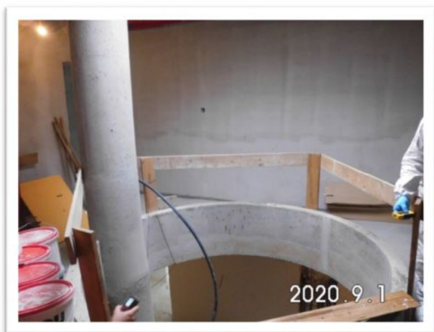
Emeleti földmáttörés (felül nézet) és bevilágító akna (alul nézet), melybe a munkavállaló beesett
