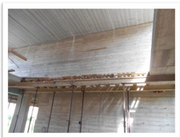
Korlát nélküli bezsaluzott födémrész és födémnyílás
