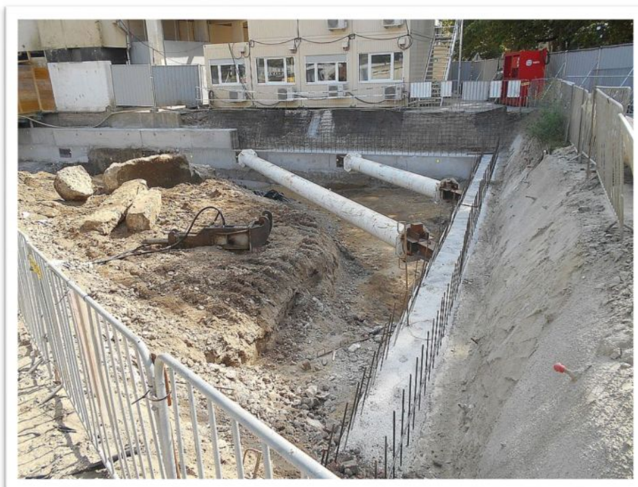
Rézsű megerősítése lőtt betonnal és talajszegekkel
