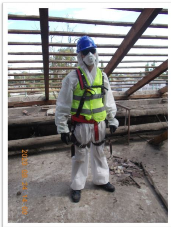
Azbeszt tartalmú pala bontási tevékenység során egyéni védőeszközök (ipari védősisak, légzésvédő, védőkesztyű, orrmerevítő védőlábbeli) megfelelő használata
